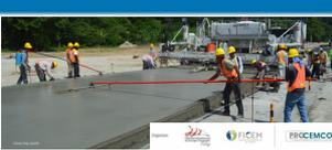
Es una técnica de rehabilitación de pavimentos que consiste en la construcción de una capa de hormigón sobre un pavimento existente con cierto grado de deterioro.
